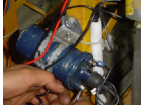
Fig.75 Realizando las conexiones
