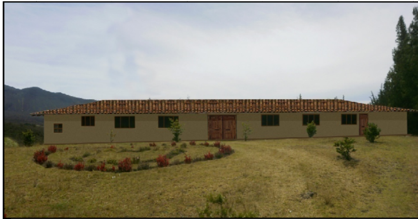
Fotografía 6.2 Exteriores del salón de uso múltiple después de las adecuaciones
