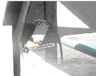
**Figura 4.2 Esquema de fin carreras para accionamiento de parada de compuerta del sedimentador # 3**
