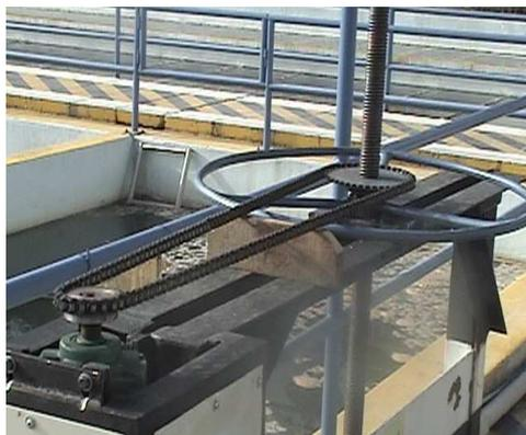
**Figura 3.11 Elemento de transmisión de movimiento: piñón catalina y cadena**
