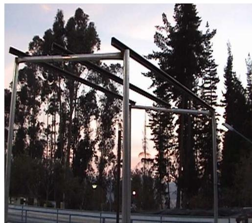
**Figura 3.3 Estructura de soporte de techo** **Figura 3.4 Correas para soporte de techo**
