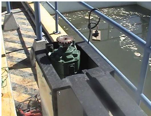
**Figura 3.10 Piñón acoplado a motor**
