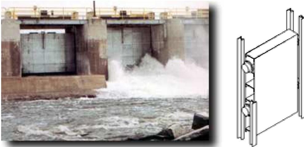
**Figura 1.2 Compuerta de rodillos roller gates**
