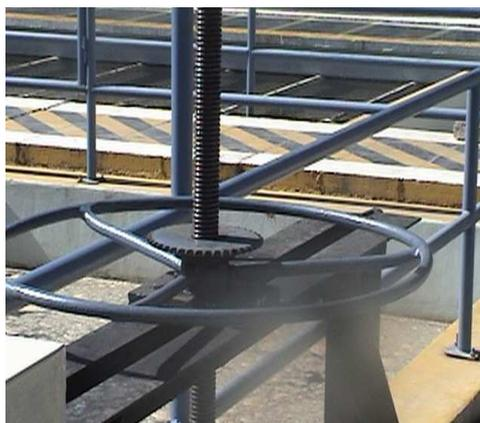
**Figura 3.9 Volante de compuerta modificado**
