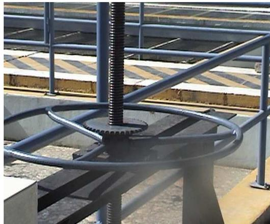
**Figura 3.7 Acople de catalina a volante existente de compuerta de sedimentador**
