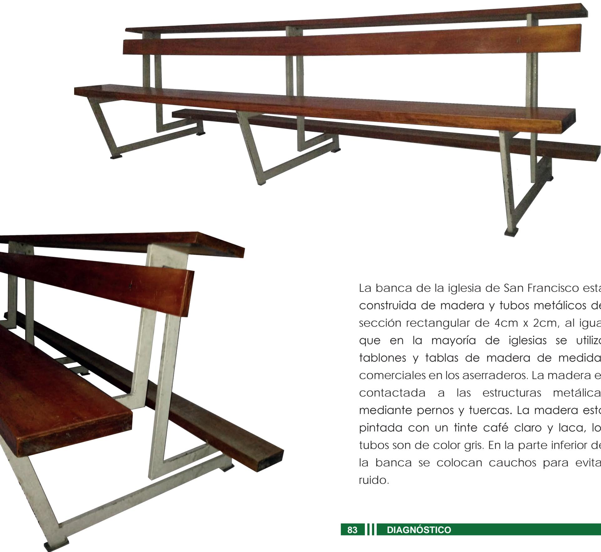
La banca de la iglesia de San Francisco esta construida de madera y tubos metálicos de sección rectangular de 4cm x 2cm, al igual que en la mayoría de iglesias se utiliza tablones y tablas de madera de medidas comerciales en los aserraderos. La madera es contactada a las estructuras metálicas mediante pernos y tuercas. La madera esta pintada con un tinte café claro y laca, los tubos son de color gris. En la parte inferior de la banca se colocan cauchos para evitar ruido.
