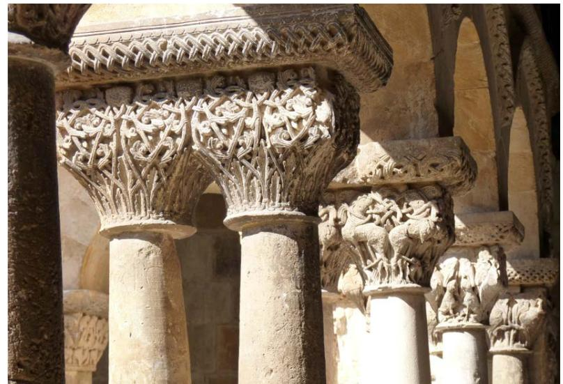
Imagen 20: El capitel es ante todo un elemento estructural en la arquitectura. Por medio del mismo se resumen empujes de paramentos o bóvedas canalizándolos hacia la estructura que lo sustenta, por lo general una columna aún cuando también pueda ser pilar o pilastra.
