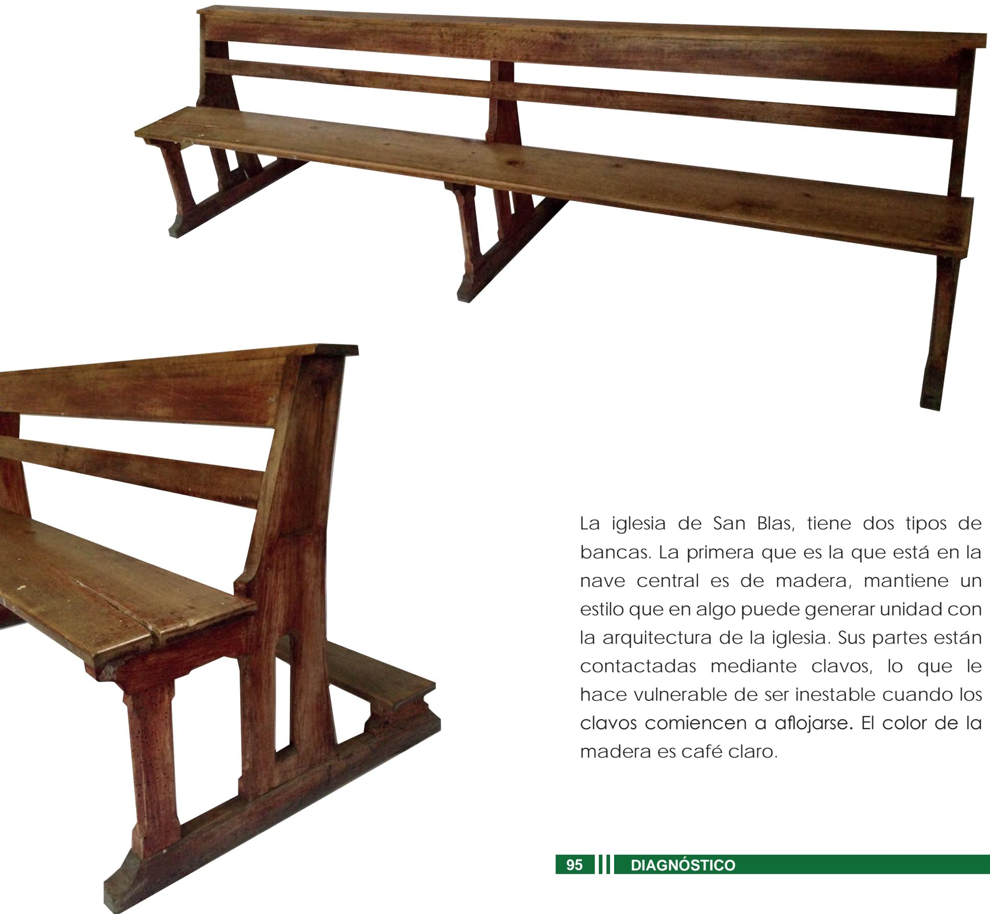
La iglesia de San Blas, tiene dos tipos de bancas. La primera que es la que está en la nave central es de madera, mantiene un estilo que en algo puede generar unidad con la arquitectura de la iglesia. Sus partes están contactadas mediante clavos, lo que le hace vulnerable de ser inestable cuando los clavos comienzen a aflojarse. El color de la madera es café claro.
