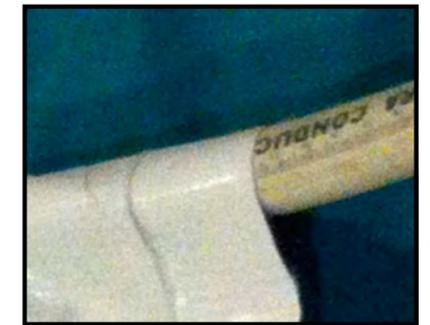
Para la unión de la lona con los tubos se debe utilizar el tipo de Unión "Rígida - Interior".
