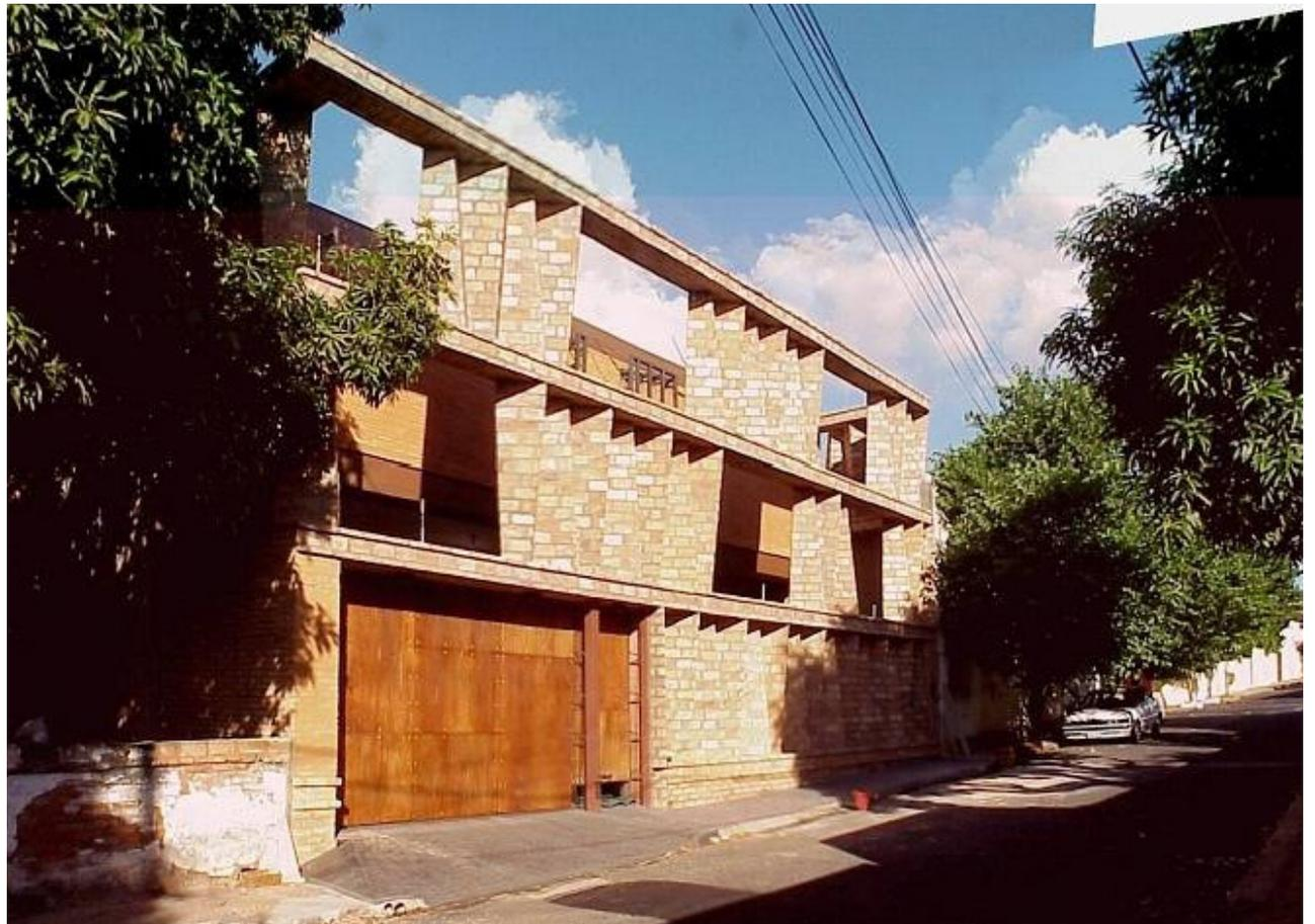
i 22. Fachada hecha con paneles de ladrillo, comprimidos por vigas
