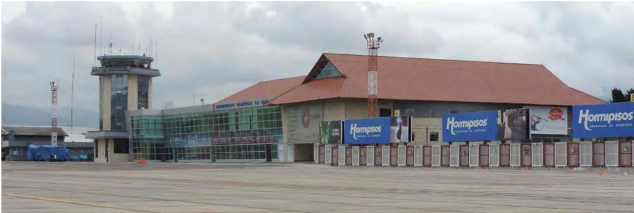
La terminal aérea se encuentra construida con materiales no adecuados, para un equipamiento de este tipo, siendo la teja un material de gran mantenimiento, por la cantidad de viento que genera las aeronaves haciendo que estas se muevan y produzcan problemas al edificio. Además de tener una cubierta inclinada que sirve únicamente de "decoración", sobre una cubierta plana que está construida en este edificio.
