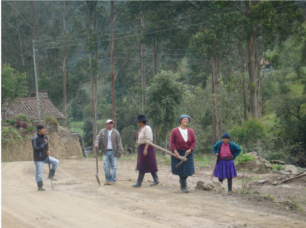
Ilustración 9: Minga para limpieza de cunetas
