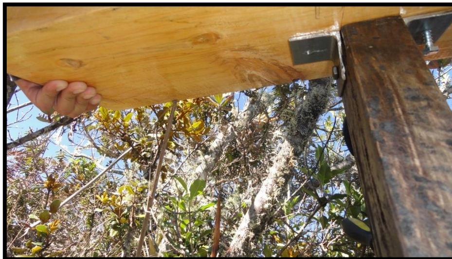
**Fotografía: 41 Ángulos de hierro que sujetan las señales**
