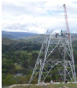
**Gráfico 1: Desmontaje Torre de Transmisión**
