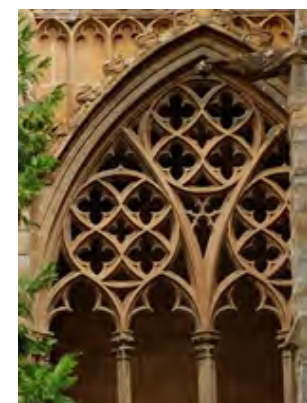
Detalle de tracería
