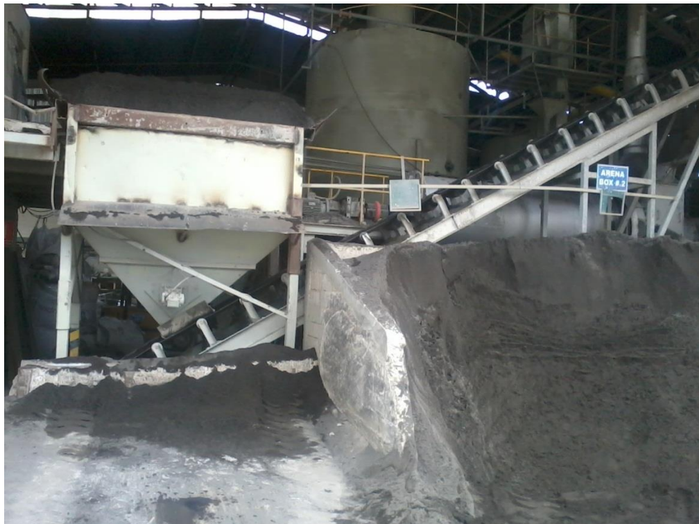
Gráfico 13. Recepción de Materia Prima en boxes, silos y tolva
