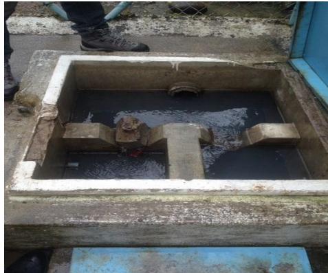
Fotografía 1. Caja recolectora existente de la captación
