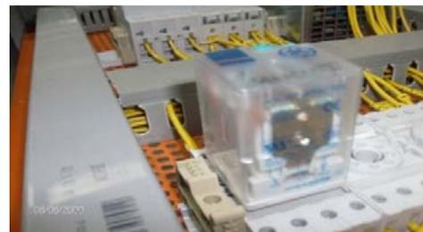
fig.30: Montaje de los relés
