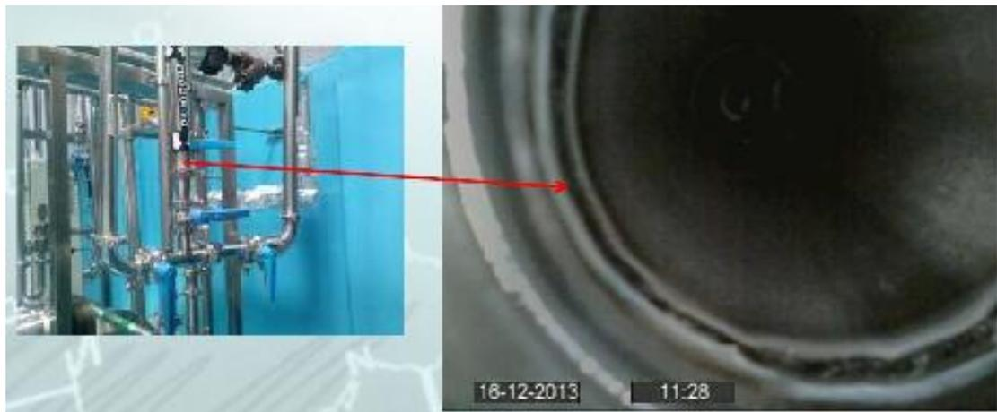
En la Figura 6, se puede observar un cordón de suelda irregular que se encuentra en una tubería de ingreso de producto, este tipo de soldadura permite que se dé la acumulación de residuos de producto (azúcares, proteína), provocando la formación de biofilm.
