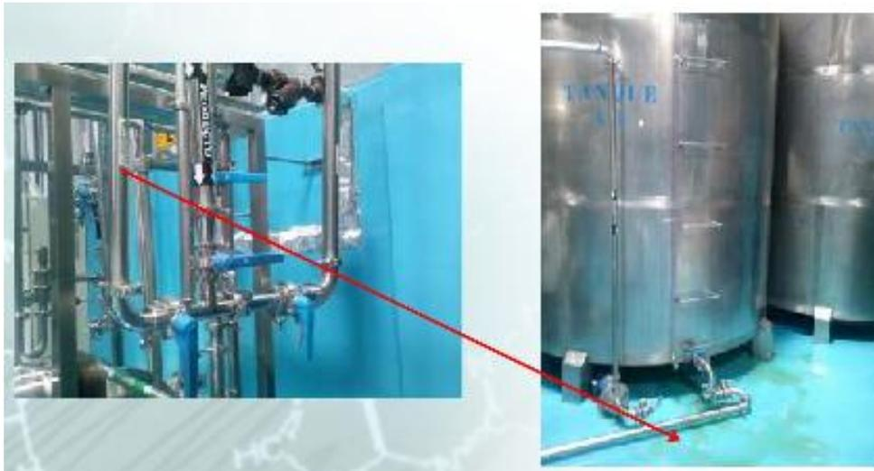
En la Figura 4, se pueden observar dos puntos en los que se encontró residuo de producto (Refresco), que debido a la distribución de la tubería hace imposible que se logre vaciar todo el contenido de la tubería.
