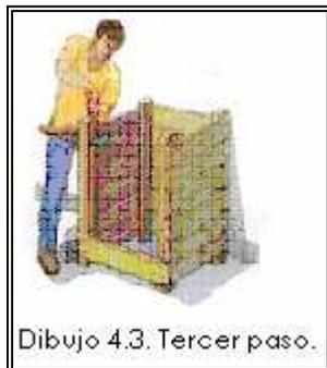
3.- Se retira la madera de sujeción, se gira el compostero y se prepara para construir la parte frontal. Para ello, se clava un travesaño en la base y los postes y las guías en cada una de las paredes laterales.
