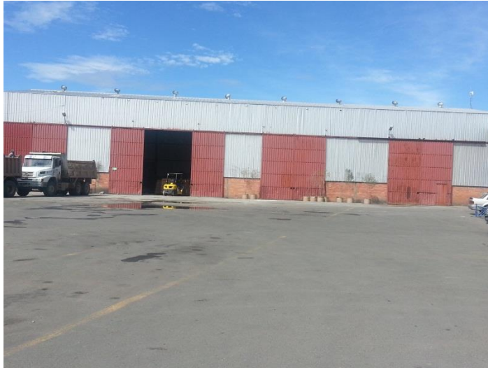
Ilustración 1: Bodega General (Ubicación: Av. Max Uhle)
