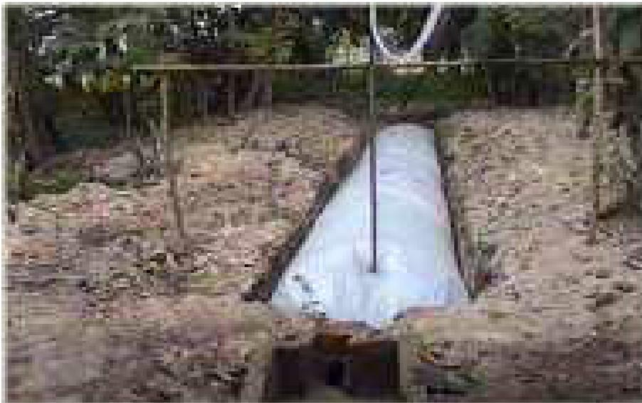
Biodigestor de polietileno
