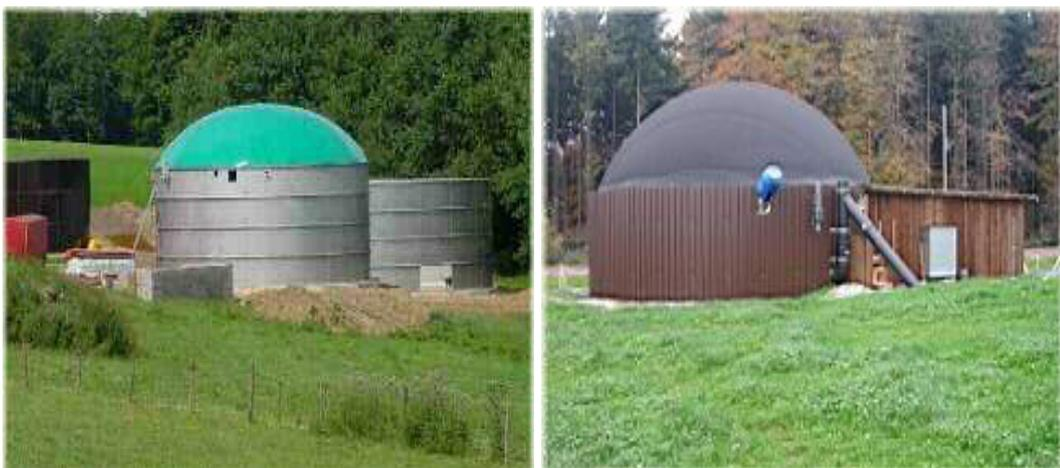
Digestor con tanque de almacenamiento tradicional y cúpula de polietileno.
