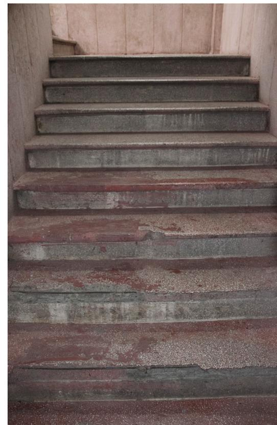
La perfleria de madera de la edificación se encuentra bastante deteriorada, por otra parte el puente de la edificación se lo ha destinado a ser pasillo y bodega. La circulación vertical esta en muy mal estado y existen peldaños que pueden causar accidentes.
