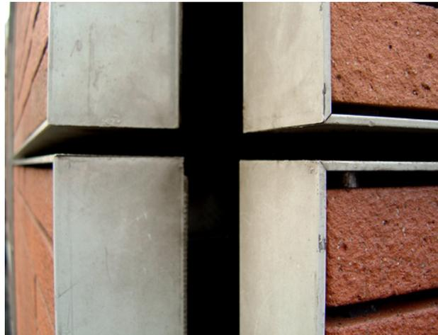
Los paneles cuelgan de la estructura del edificio y actúan como una pantalla. Cada panel está compuesto por doce cerámicas. Cada pieza es de 275 x 50 x 50 mm y se mantiene dentro del marco de aluminio y está atravesada por perfilera metálica.
