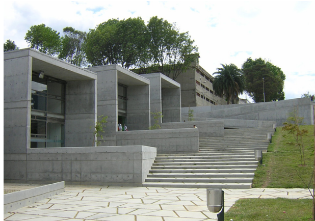
Conexión con las escalinatas.
