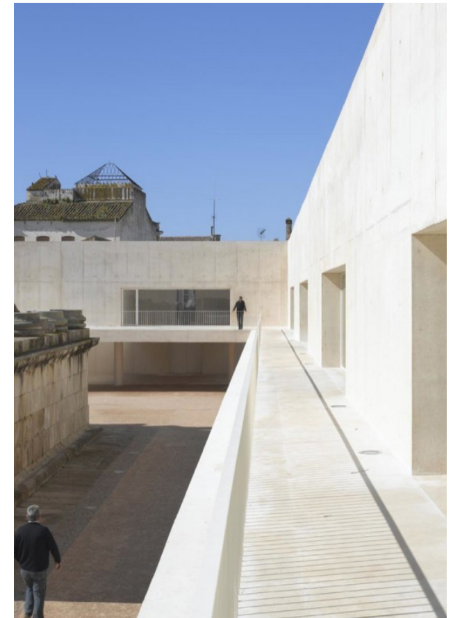
Conformación de la nueva edificación
