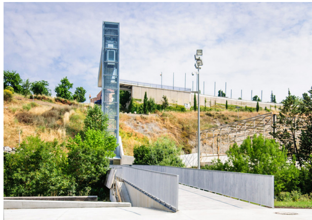
Ingreso hacia el ascensor.
