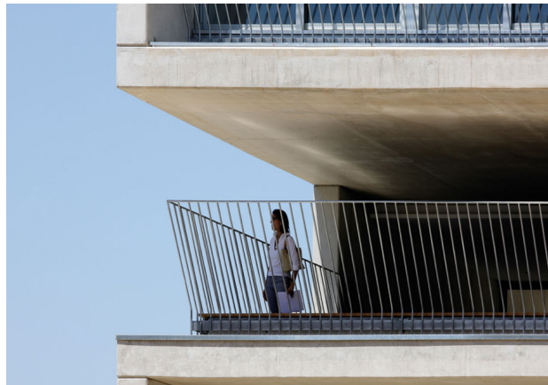
Abertura en una esquina.
