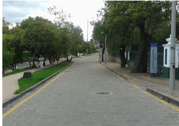
Calle paseo 3 de Noviembre.
