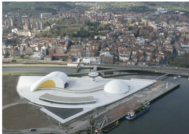
Vista aérea del proyecto.
