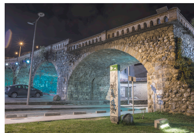
3- Barranco de la ciudad de Cuenca/ Puente Roto
