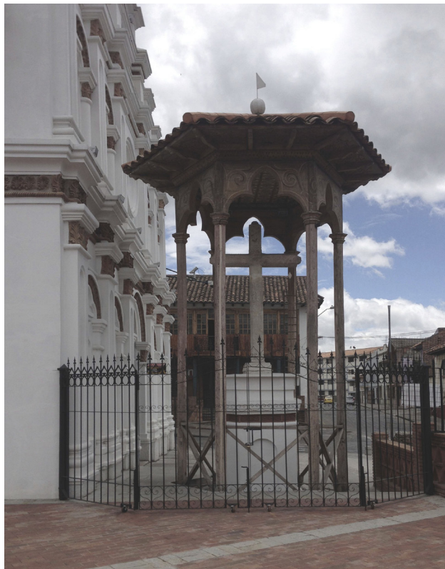
acceso desde la bajada de Todos Santos hacia la plaza del complejo
