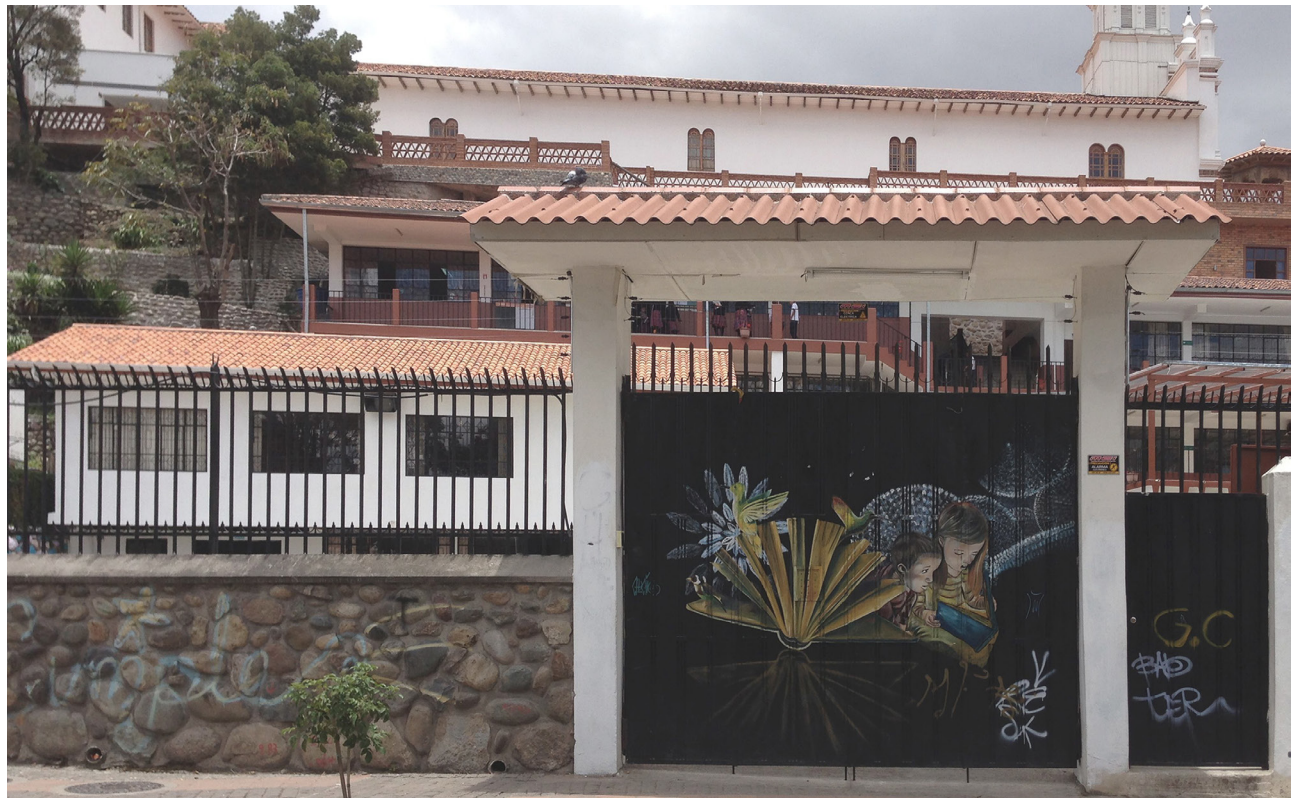
acceso principal a la escuela desde la Av. 3 de Noviembre
