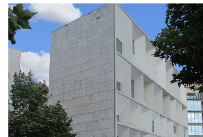
Auditorio de León Mansilla y Tuñón arquitectos 1994-2002
