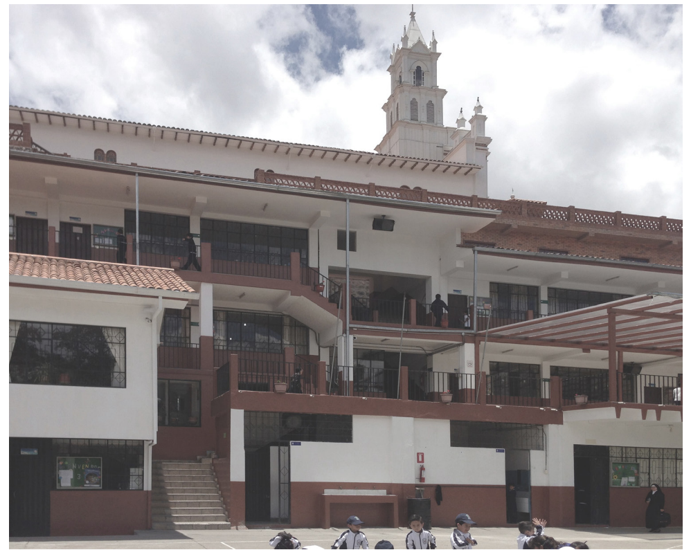
muro fachada Av 3 de Noviembre
