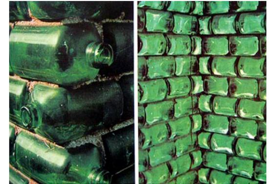
IMAGEN 11: CONSTRUCCION CON BOTELLAS HOBO
