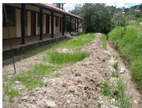
*Es necesario abrir un canal de drenaje para evitar daños por el agua*
