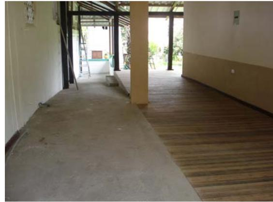
*Las antiguas gradas fueron sustituidas por una rampa*
