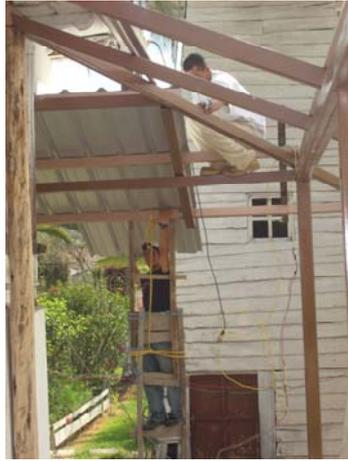
*La antigua estructura de madera se sustituyó por una de metal*
