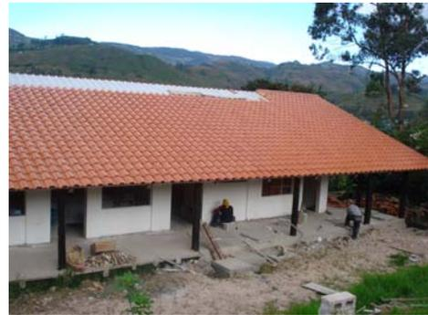
*En la cubierta se colocó lámina de zinc y encima teja nueva.*
