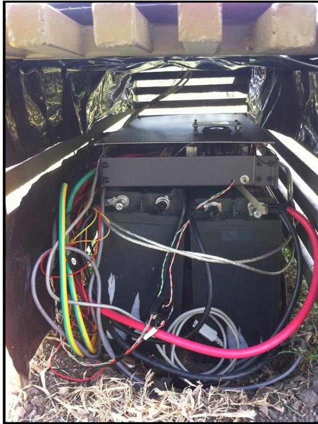
Figura 4.15 Fase 2. Módulo, banco de baterías, sensores y equipo ubicados debajo de la banca, funcionando en un solo conjunto.
