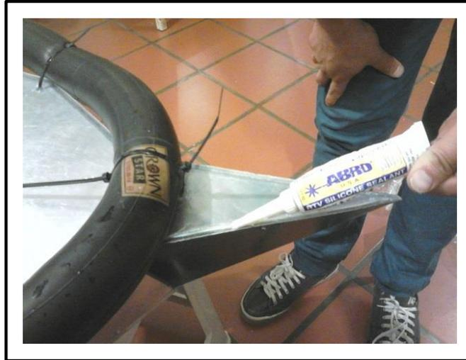
Figura 3.38. Aislamiento del módulo móvil acuático (silicón frío).
