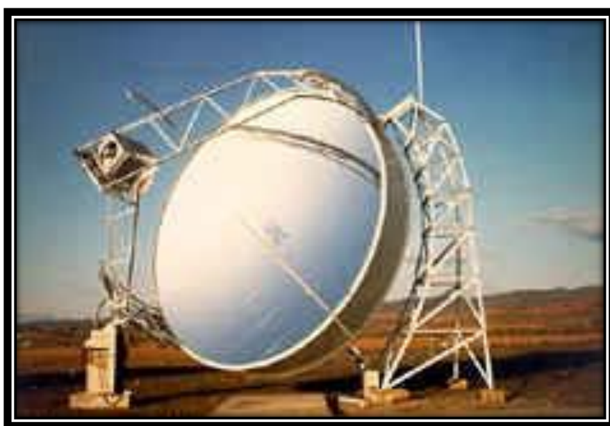
Figura 1.4: Disco Parabólico Stirling
