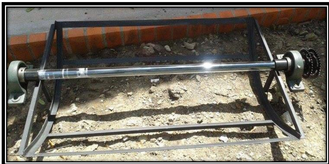
Figura 2.9 Construcción del marco metálico e instalación del tubo absorbente Fuente: Autor
