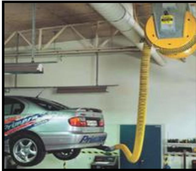
Figura 15: Evacuación de gases
