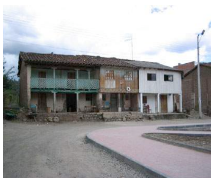
Antiguas casas del centro parroquial restauradas por sus dueños
