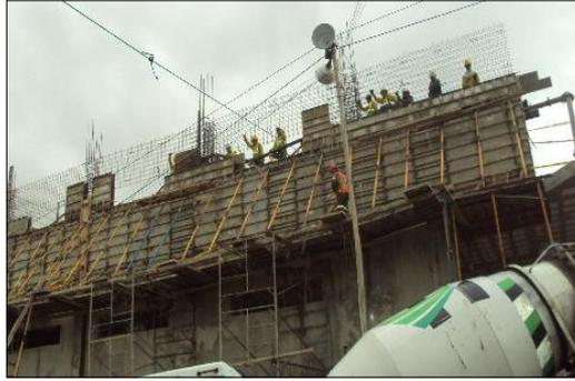
Figura 20.- Encofrado y fundición de muro N=7,20. (16/07/13)
