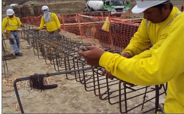
Figura 2.- Armado de acero de refuerzo (Columnas tipo 4 40x60 cm) (15/01/2013)
