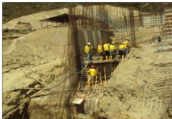
Figura 7.- Fundición de muro eje L- (12/03/2013)
