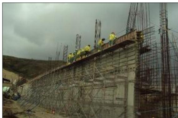
Figura 13.- Encofrado y fundición de tramo de muro y viga eje 6. C-L. (02/05/2013)
