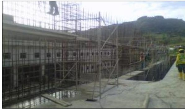
Figura 23.- Acero de refuerzo para celdas en primera planta alta. (17/10/2013)
