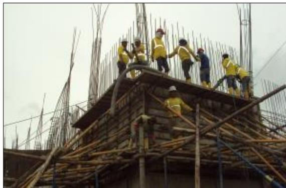
Figura 9.- Encofrado y fundición de muro esquinero 6N. (04/04/2013)
