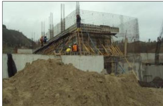
Figura 21.- Fundición de Muro Eje A N=+7,20. (05/08/2013)
