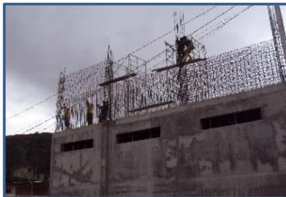
Figura 19.- Colocación de Malla N=7,20. (14/07/2013)
