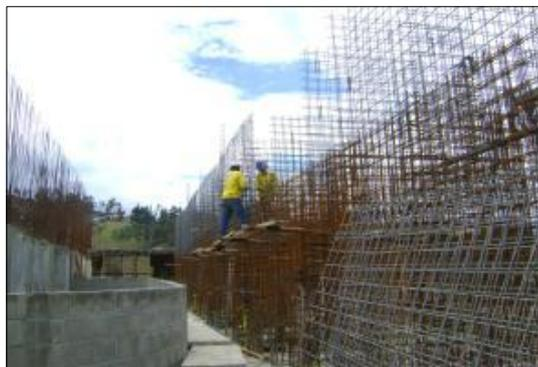
Figura 22.- Acero de refuerzo para celdas en primera planta alta. (13/10/2013)
