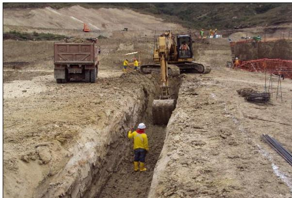
Figura 1.- Excavación a máquina para zapatas. (15/01/2012)
