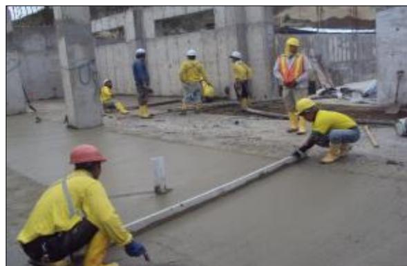
Figura 16.- Fundición planta baja N=0,00. (06/06/2013)
