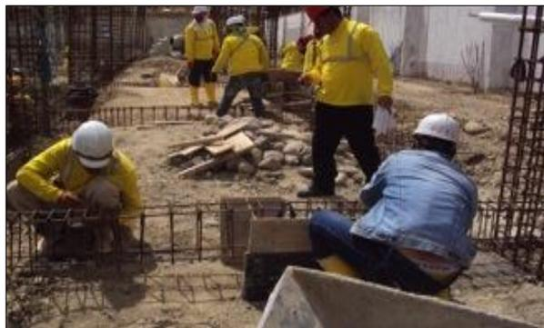
Figura 12.- Armado de vigas cimentación. (30/04/2013)
