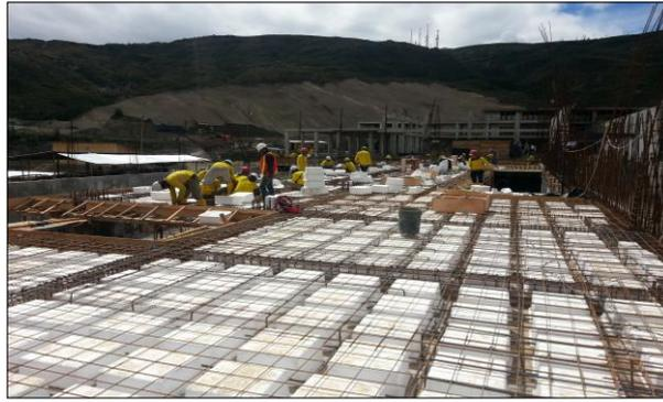
Figura 17.- Colocación de casetones en losa. (30/06/2013)
