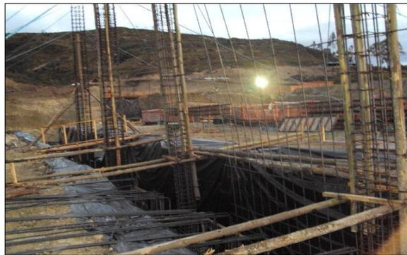
Figura 3.- Levantamiento de muro, varillas diámetro 14mm. (23/01/2013)
