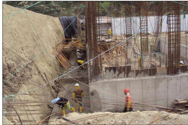
Figura 6.- Desencofrado muro. (27/02/2013)
