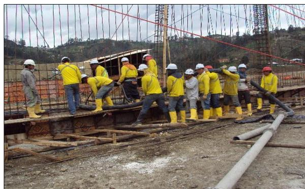
Figura 4.- Fundición de muro del eje 1 longitudinal. (31/01/2013)
