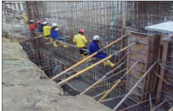
Figura 18.- Armado de acero de refuerzo muro. (05/07/2013)
