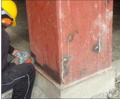
Figura 4-11: Remoción de impurezas adheridas a junta soldada en obra
