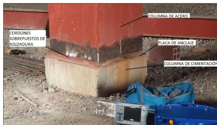
Figura 1-11: Detalle de conexión columna-placa de anclaje en obra
