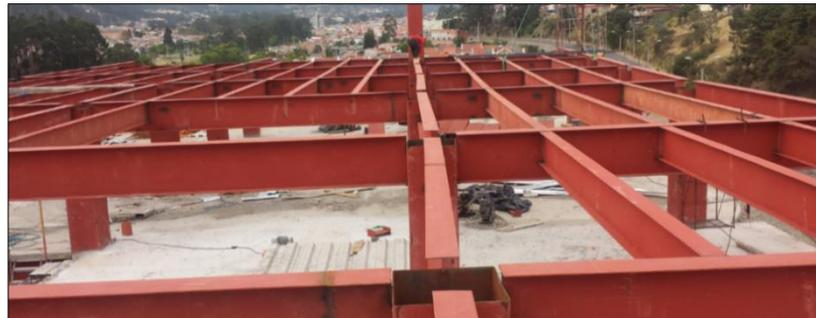
Figura 1-9: Detalle de montaje de vigas y columnas de acero
