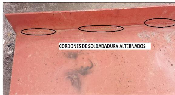
Figura 1-6: Cordones de soldadura alternados en viga tipo I en obra
