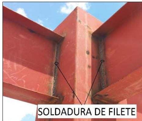
Figura 2-6: Soldadura de filete en obra
