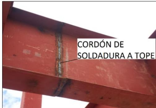
Figura 2-3: Cordón de soldadura de ranura, empalme viga-viga
