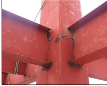
Figura 1-16: Aplicación de electrodos E-6011 para montaje viga-columna en obra
