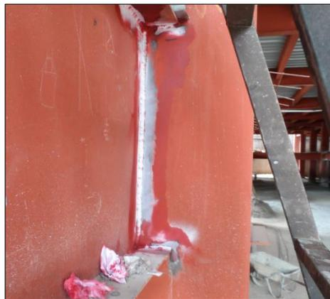
Figura 4-7: Aplicación de revelador en obra
