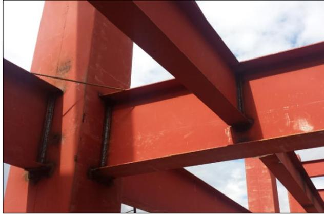
Figura 1-18: Aplicación de electrodos E-7018 para montaje viga-columna en obra
