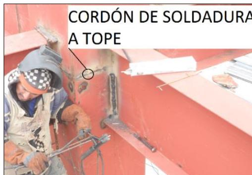
Figura 2-4: Cordón de soldadura de ranura, empalme columna-columna
