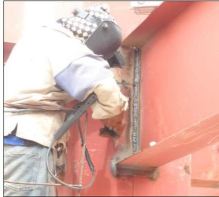
Figura 1-10: Conexión de viga y columna de acero con soldadura de filete en obra
