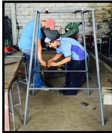
Figura 21: Elaboración de la estructura metálica
