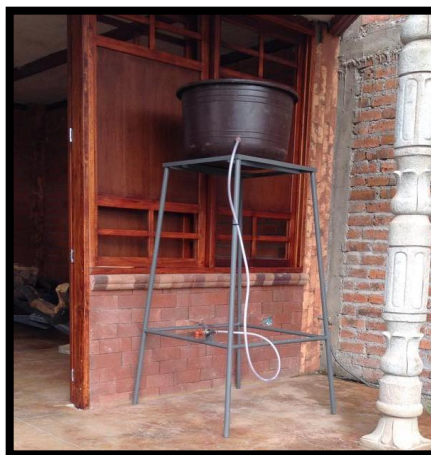
Figura 22: Tanque de almacenamiento de 100 l de capacidad
