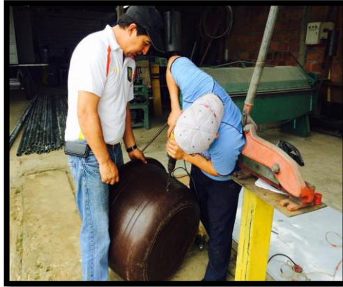
Figura 23: Perforación de orificio de salida del agua en el tanque
