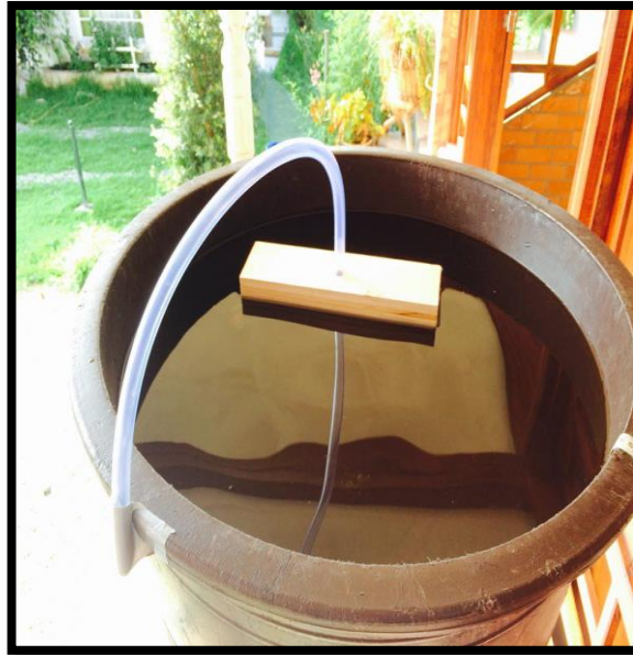
Figura 35: Colocación del flotador con la tubería en el tanque, diseño 2
