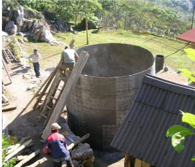
Figura 5: Tanque superficial de ferrocemento
