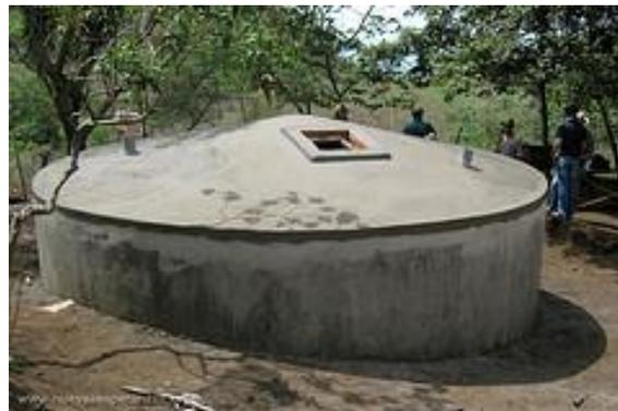
Figura 6: Tanque semienterrado de ferrocemento
