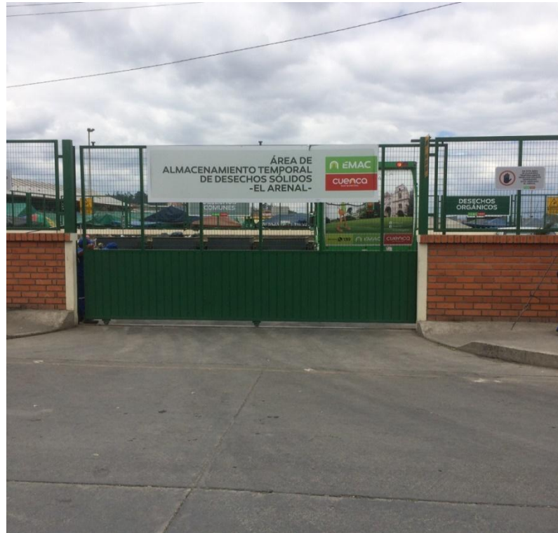
Figura 7.1: Puerta de ingreso de vehículos a la zona de almacenamiento.
