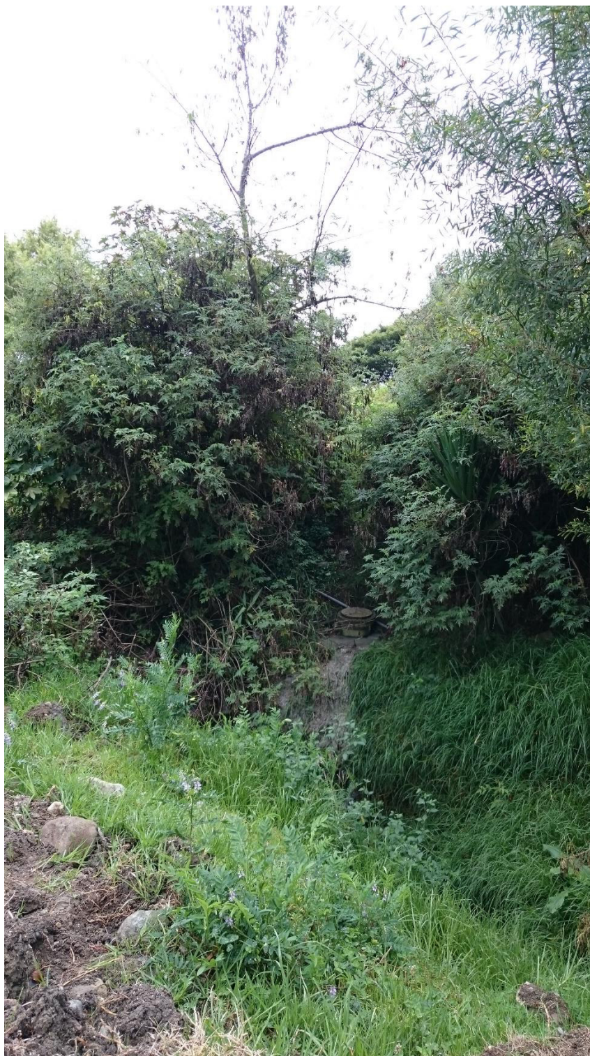
Foto: Alcantarilla colapsada, quebrada El Muerto
