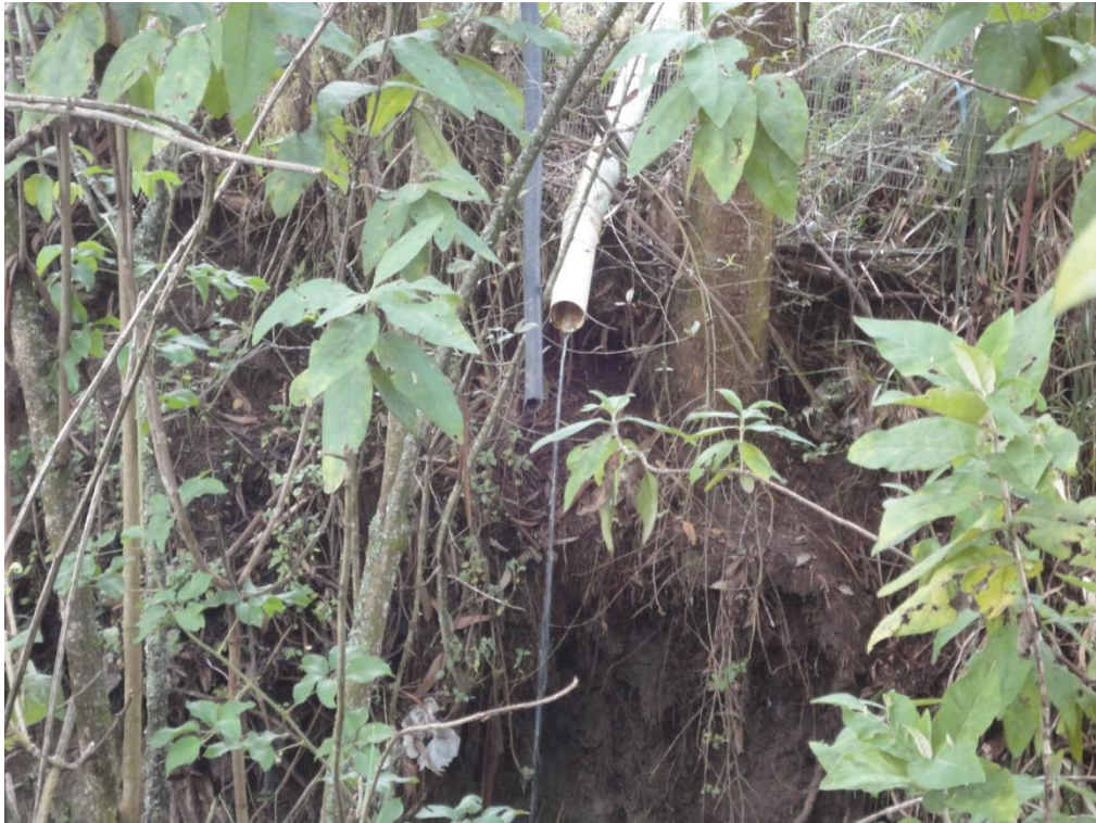
Foto: Descarga puntual, quebrada El Muerto
