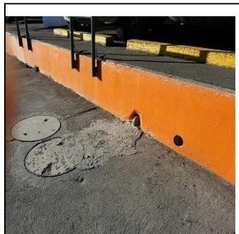
Salida a la calle de la tubería del pozo de aguas negras, para la extracción al alcantarillado público
