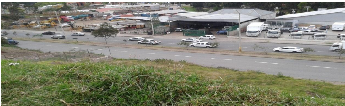
Figura 2.8. Naves industriales ubicadas en la avenida de las Américas sector de Quinta Chica.
