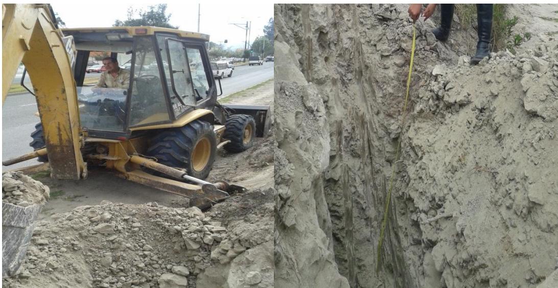
Figura 2.5. Toma de muestras de suelo realizado en el sector de Quinta Chica.
