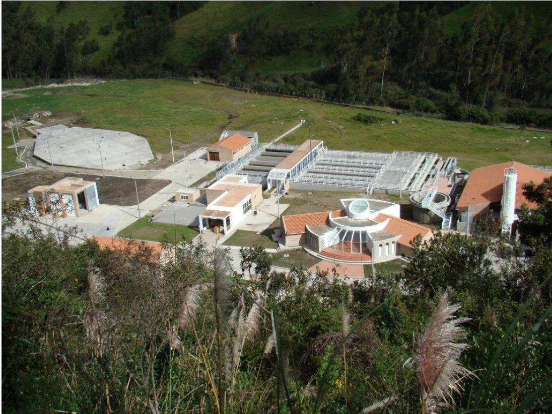
Gráfico 1.5 Planta de Tratamiento de Agua Potable de Sustag
