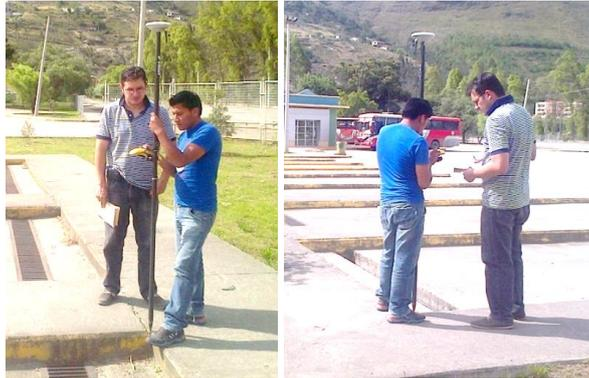
**FIGURA 32. Levantamiento usando GPS diferencial en el Terminal de Paute.**
