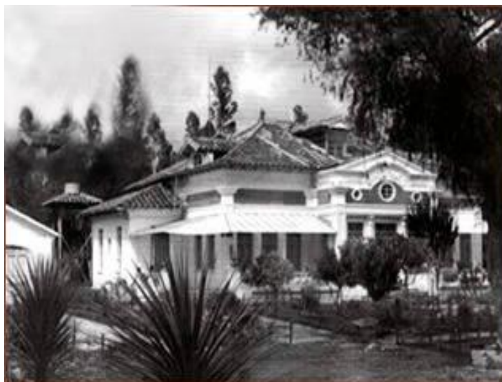
Imagen No 1: Hospital Santa Inés 1967
