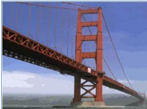
Figura 1.13: Puente con estructura de Acero.
