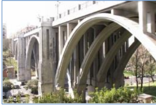
Figura 1.14: Puente de Hormigón Armado.
