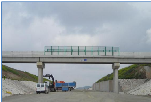
Figura 1.15: Puente de Hormigón pretensado.
