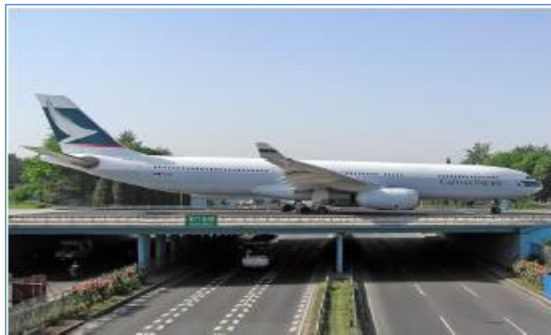
Figura 1.10: Puente para aviones.
