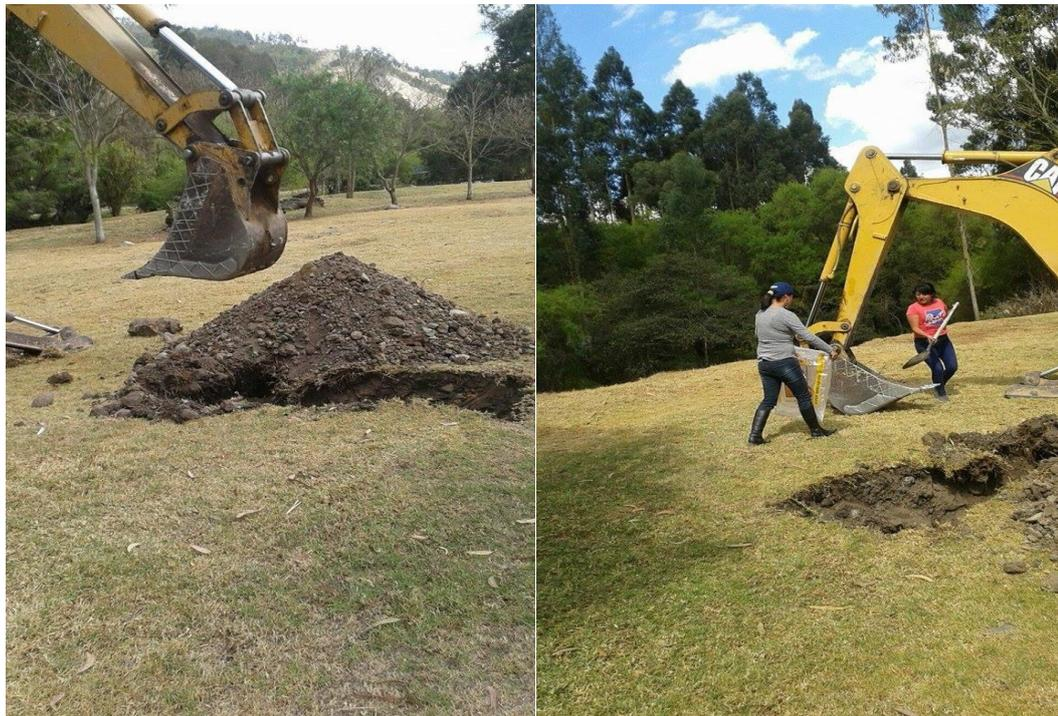
Figura 2.4. Excavación de calicatas para la toma de muestra.
