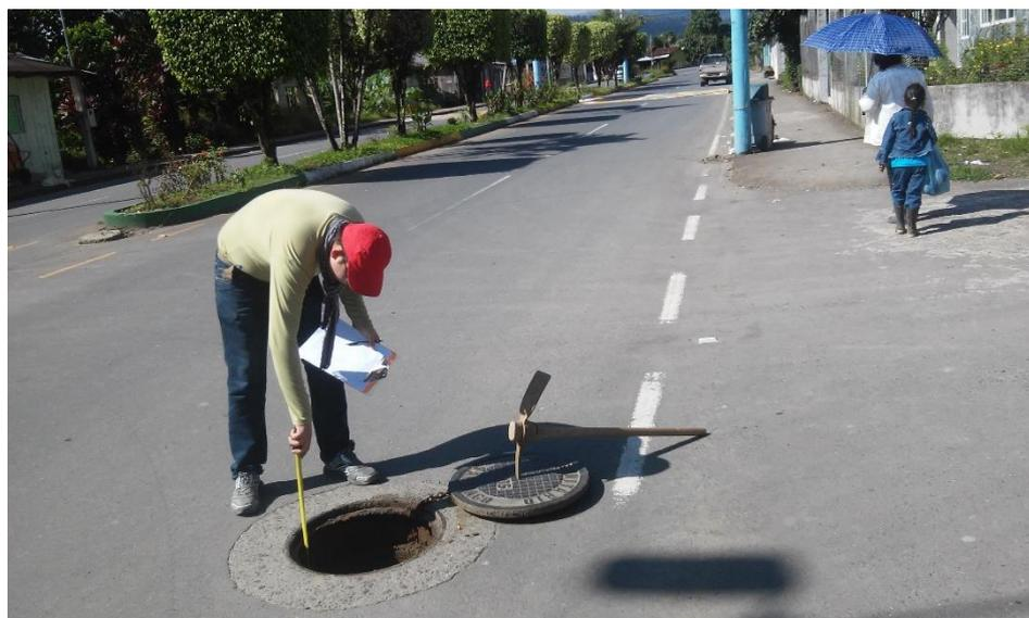
Figura 2.3: Catastro pozos de alcantarillado sanitario
