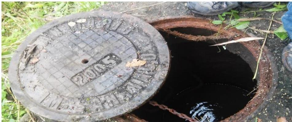
Figura 2.23: Pozo de alcantarillado sanitario
