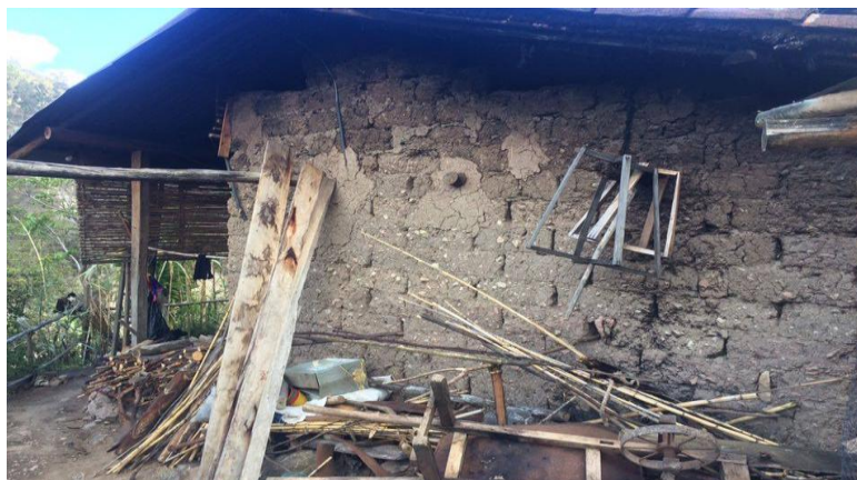
Fotografía 26.- Fachada la casa
