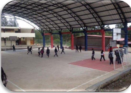
Anexo 13: Fotografía Patio Cubierto Unidad Educativa "Chiquintad"; Fuente las Autoras
