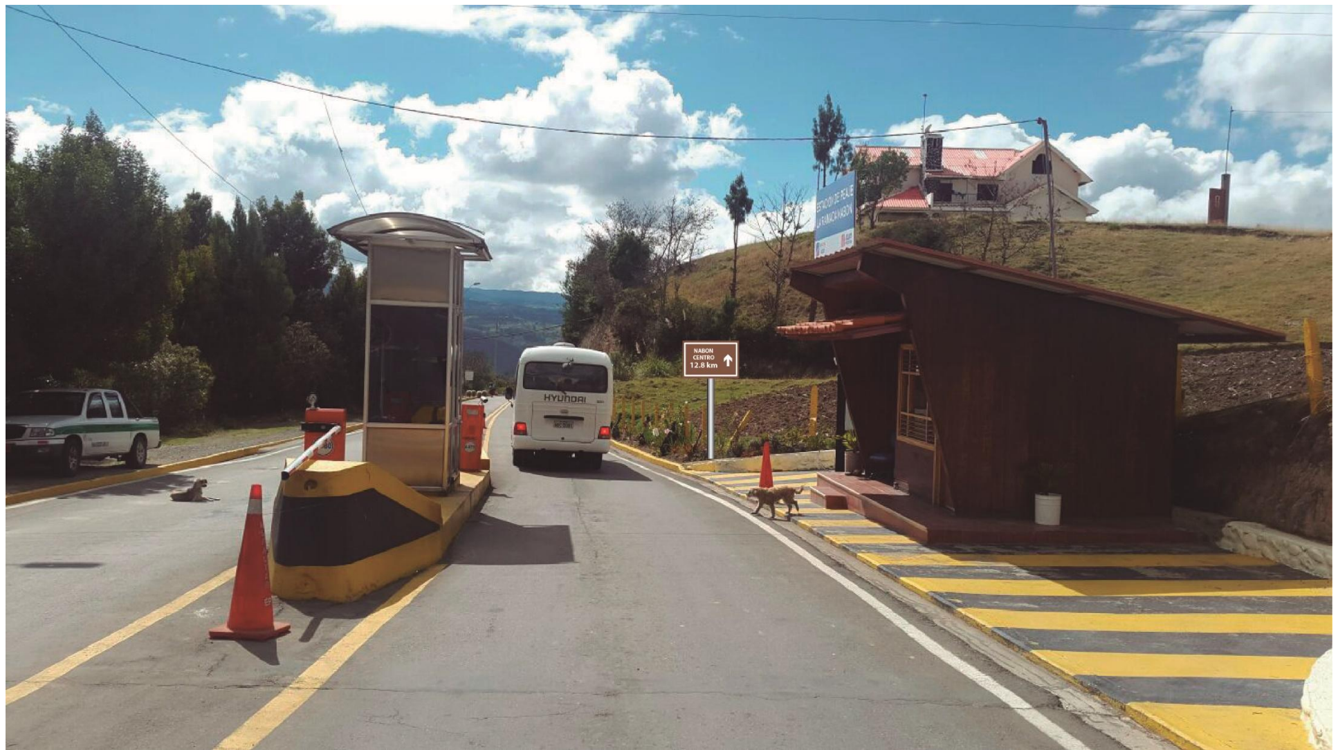
Autor: Dis. José Torres. Fuente: Propia Montaje de señalética peaje Nabón
