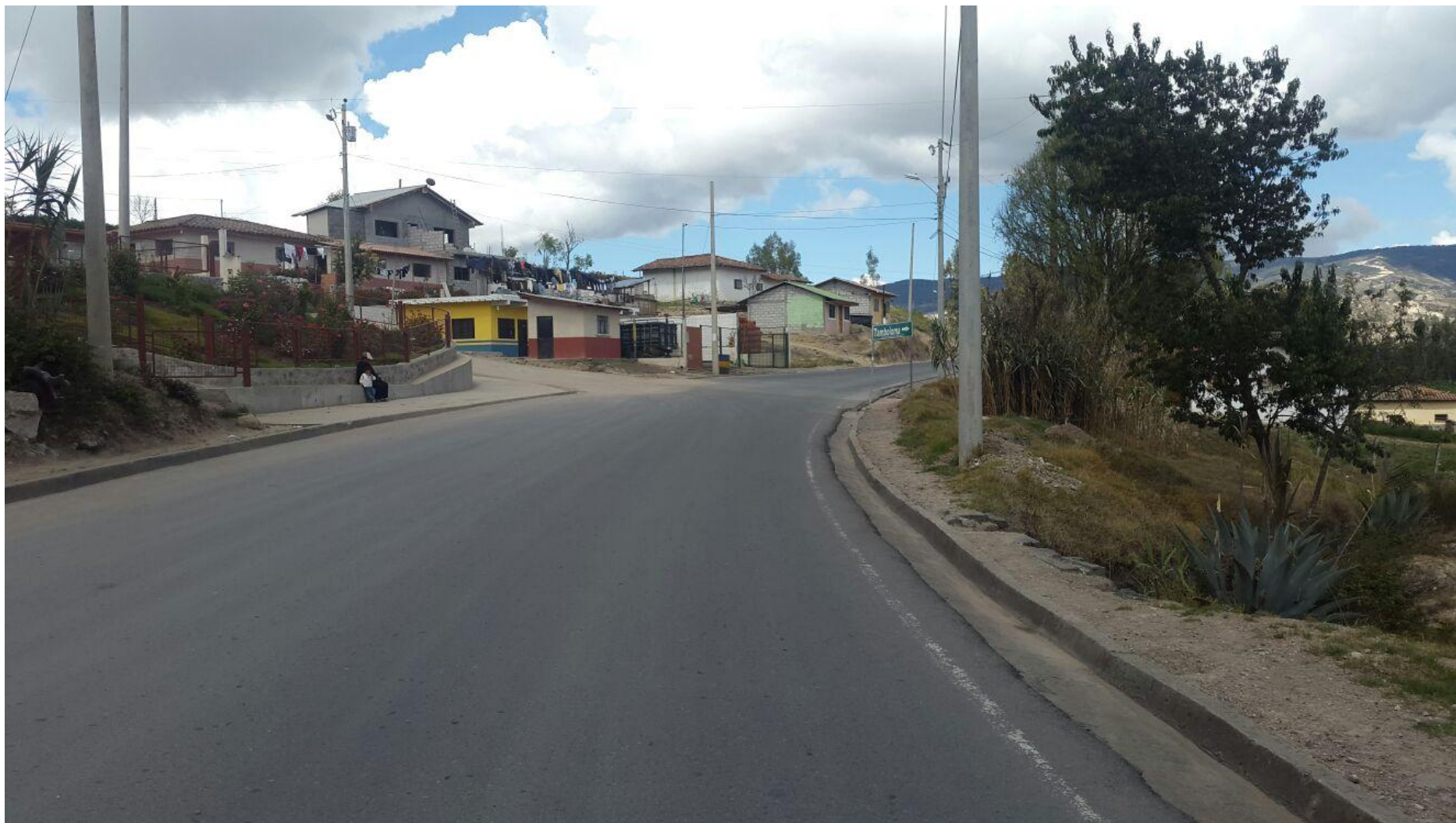
Autoras: Guzmán, Vega. Fuente: Propia Terminal Terrestre de Nabón
