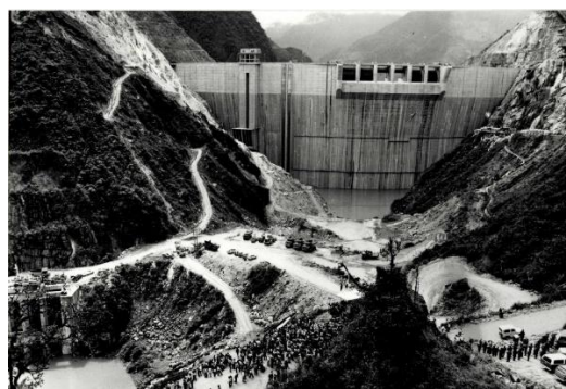
Figura 1.4: Construcción de la Represa Daniel Palacios
