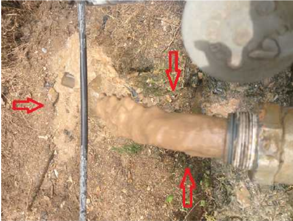
Figura 4.4: Acumulación de sólidos en el tapón final.
