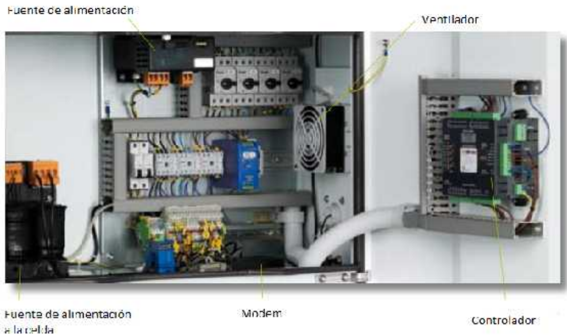
Figura 3.2: Principales Componentes para el control de la máquina generadora de agua electrolizada
