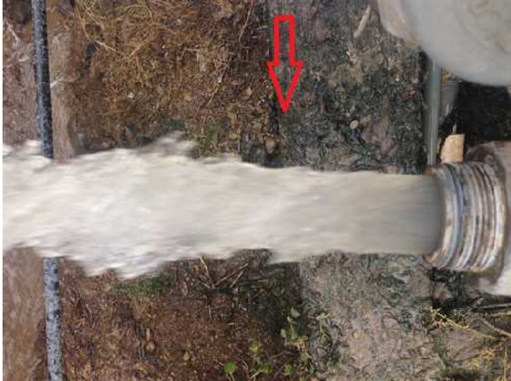
Figura 4.5: Inexistencia de acumulación de sólidos.
