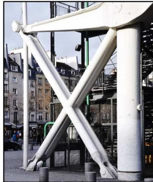
Figura 1.7: Diagonales rigidizadoras
