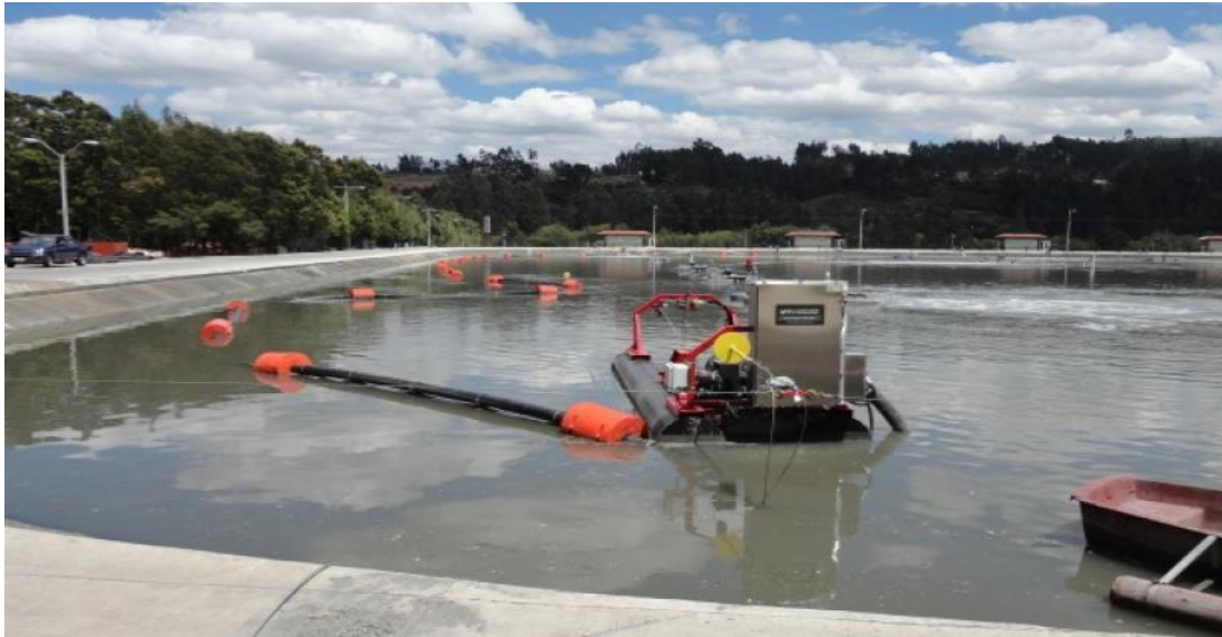
Ilustración 5 Instalaciones de la planta de tratamiento de aguas residuales de Ucubamba ETAPA EP.
