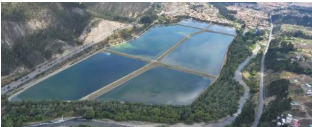
Ilustración 4 Instalaciones de la planta de tratamiento de aguas residuales de Ucubamba ETAPA EP.
